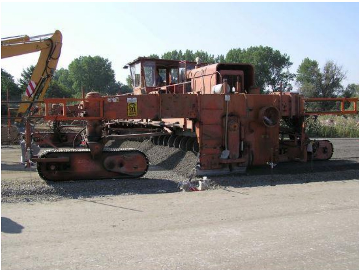
Obrázek 11 - finišér využitý na stavbě - zdroj: Dušan Stehlík - Praktické aplikace v pozemních komunikacích
