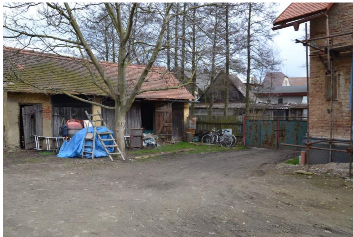
Obr. 32 V současnosti hlavní vstup musel vzniknout až po změně cestního systému
