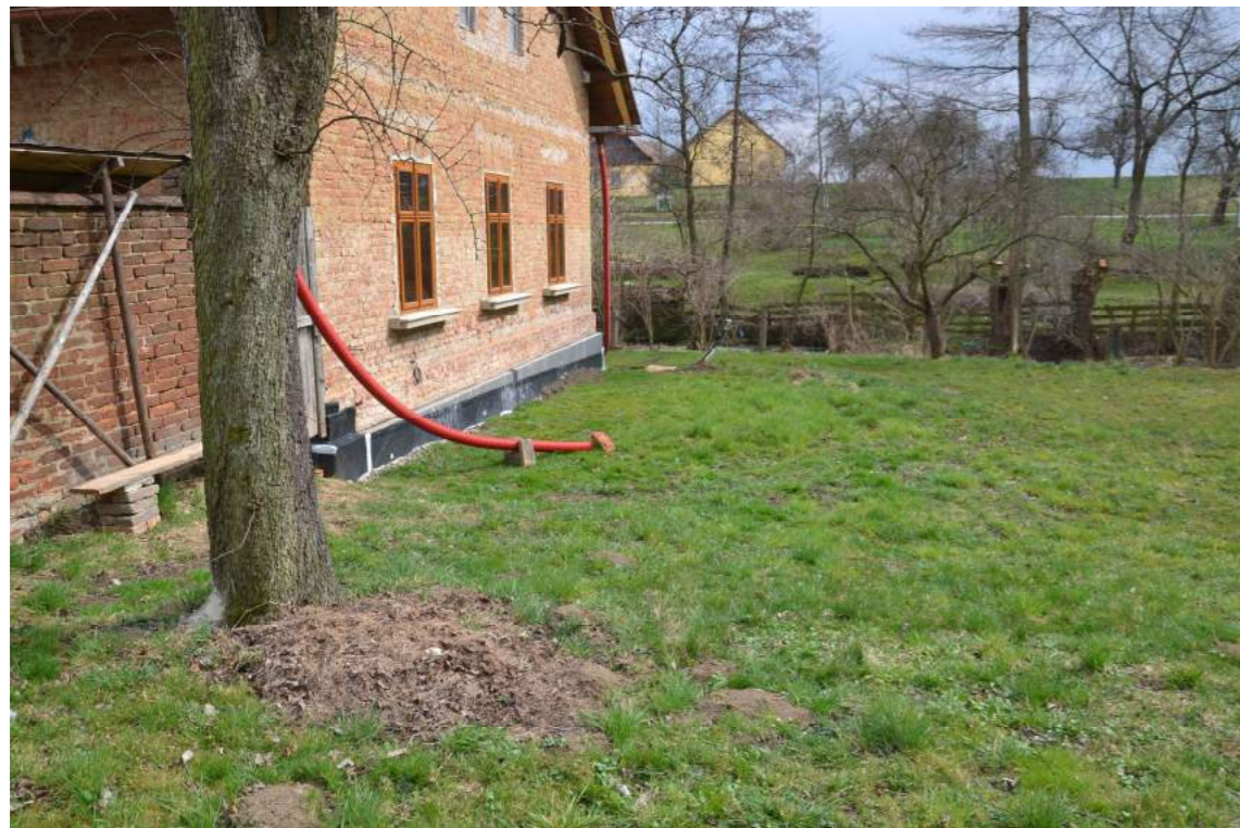
Obr. 28 Před původně čelní stěnou domu se nachází rovinatá plocha.
