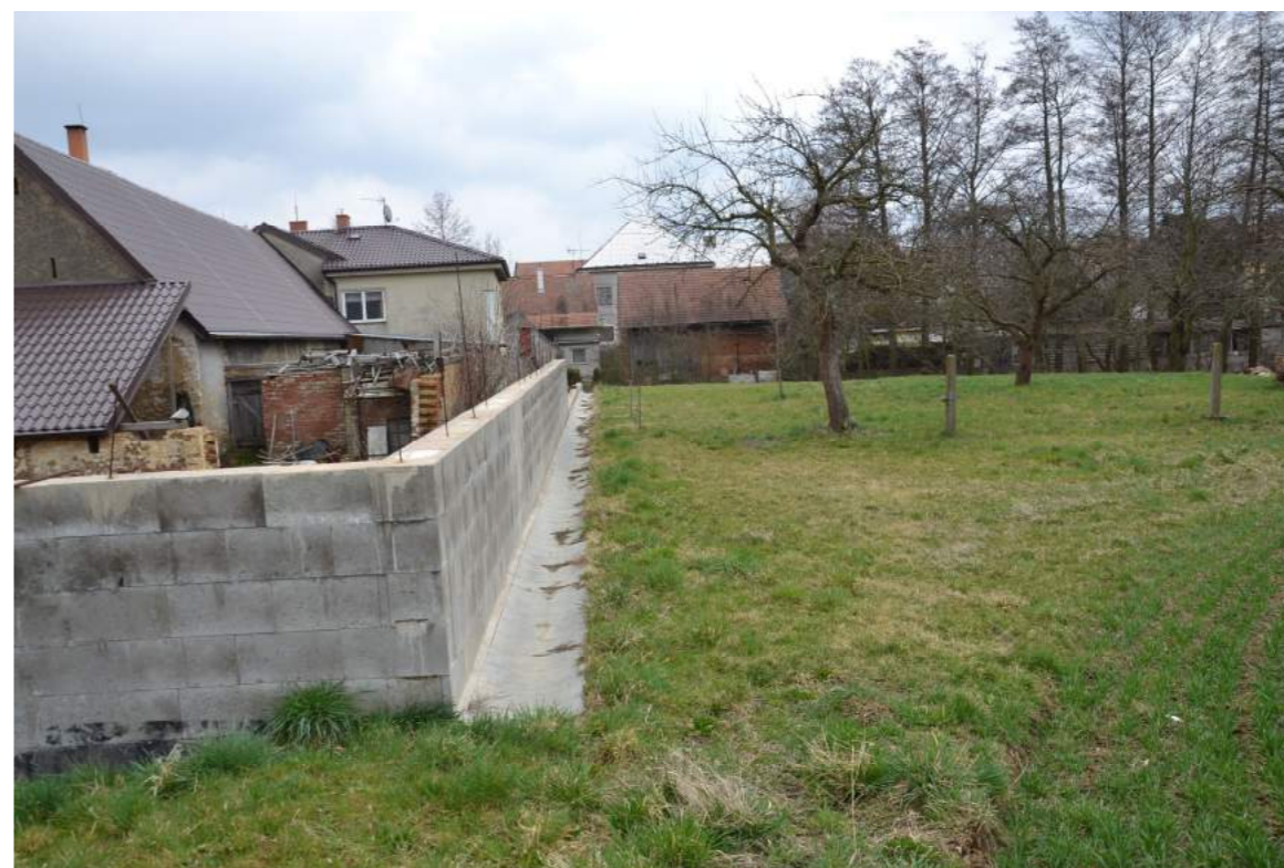
Obr. 17 Soused vyřešil problémy s přívalovou vodou zbudováním zdi s odvodňovacím příkopem.
