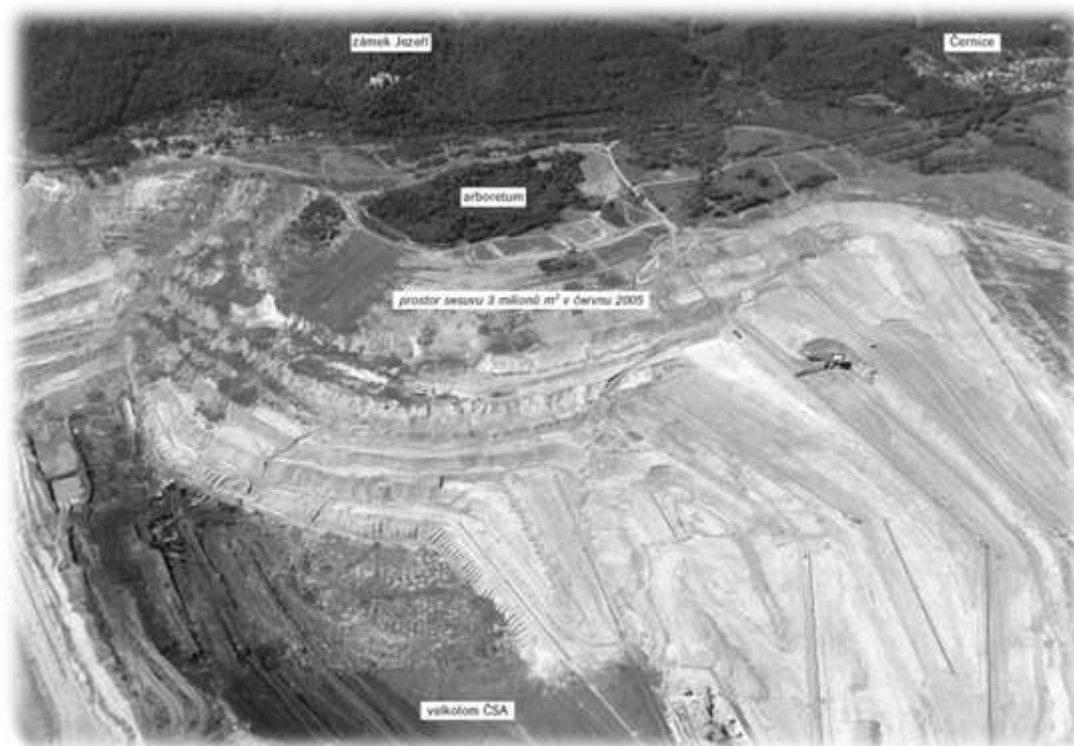
Obrázek 43 Černice, letecký snímek, Pohled přes VČSA, v popředí Arboretum a Zámek Jezeří, zcela vpravo obec Černice, Limity těžby 2005
