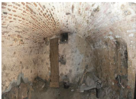
Obr.č.15 - Jižní sklep domu čp.1.
