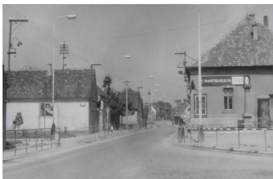
Obr.č.23: Dům č.p.1 – rok 1975
