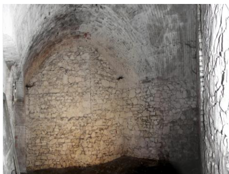
Obr.č.16 - Severní sklep domu čp.1.
