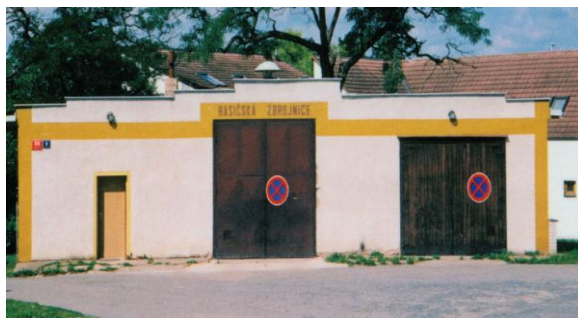
Obr.č.23 – Hasičská zbrojnice, 2013
