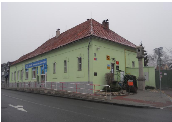
Obr.č.24 : Dům č.p.1 – rok 2013
