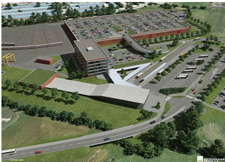
Obr.č. 9: Stanice Depo Písnice (DP Praha 2013).
