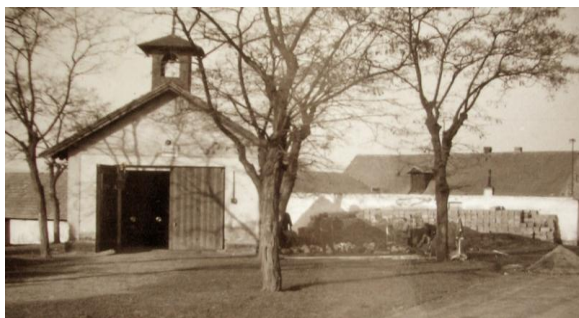
Obr.č.22 – Hasičská zbrojnice, 1930
