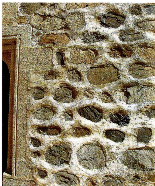
Obrázek 8: Renovovaná roztíraná malta na kamenném zdivu (hrad Točnick)
