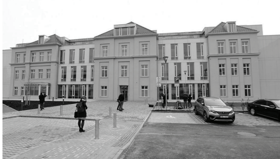
Rekonstruovaný Bakešův pavilon, Ing Arch. Vladislav Vrána, 2021
