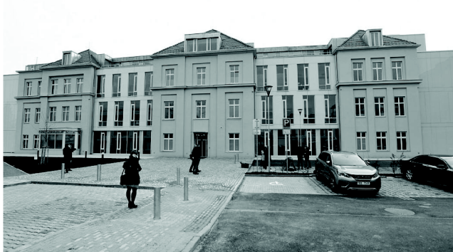
Rekonstruovaný Bakešův pavilon, Ing Arch. Vladislav Vrána, 2021
