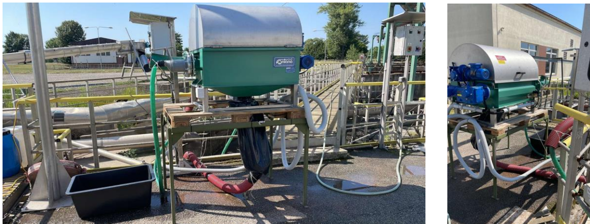
Obr. 28 Instalace stíraného válcového síta-SVSLs s mikro sítím 0,3 mm, výrobce Fontana R, s. r. o
