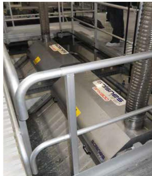
Obr. 7 Salsnes Filter pro instalaci v betonovém kanálu na ČOV Salmar, Follafoss, Norsko 2850 \text{ m}^3 \cdot \text{h}^{-1} ( Salsnes Filter , 2017)
