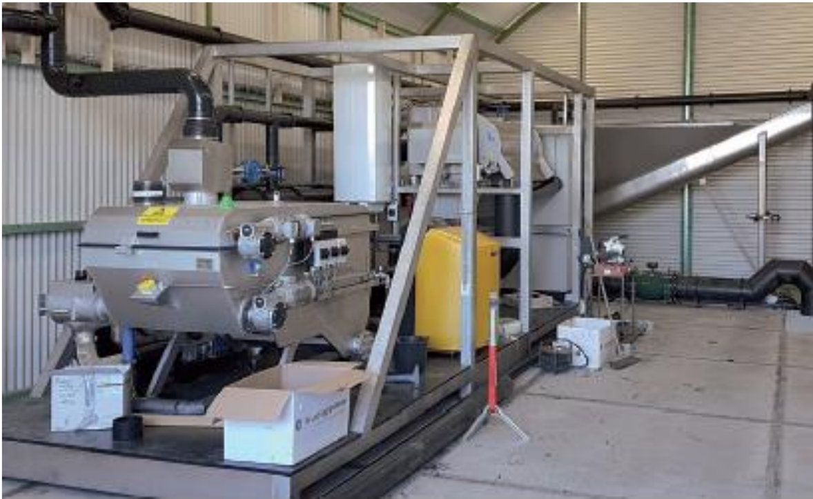
Obr. 20 Získávání celulózy dynamickým proséváním v primárním čištění, ČOV Geestmerambacht, Nizozemsko (Pikaar et al., 2022)
