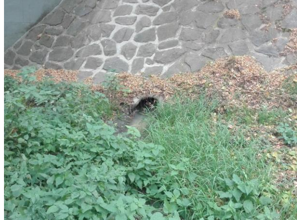
Obrázek 6-6 Stávající výustní objekt VO4
