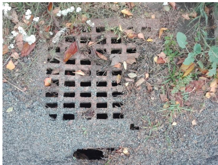
Obrázek 3-4 Šachta ŠP – Pačlavice
