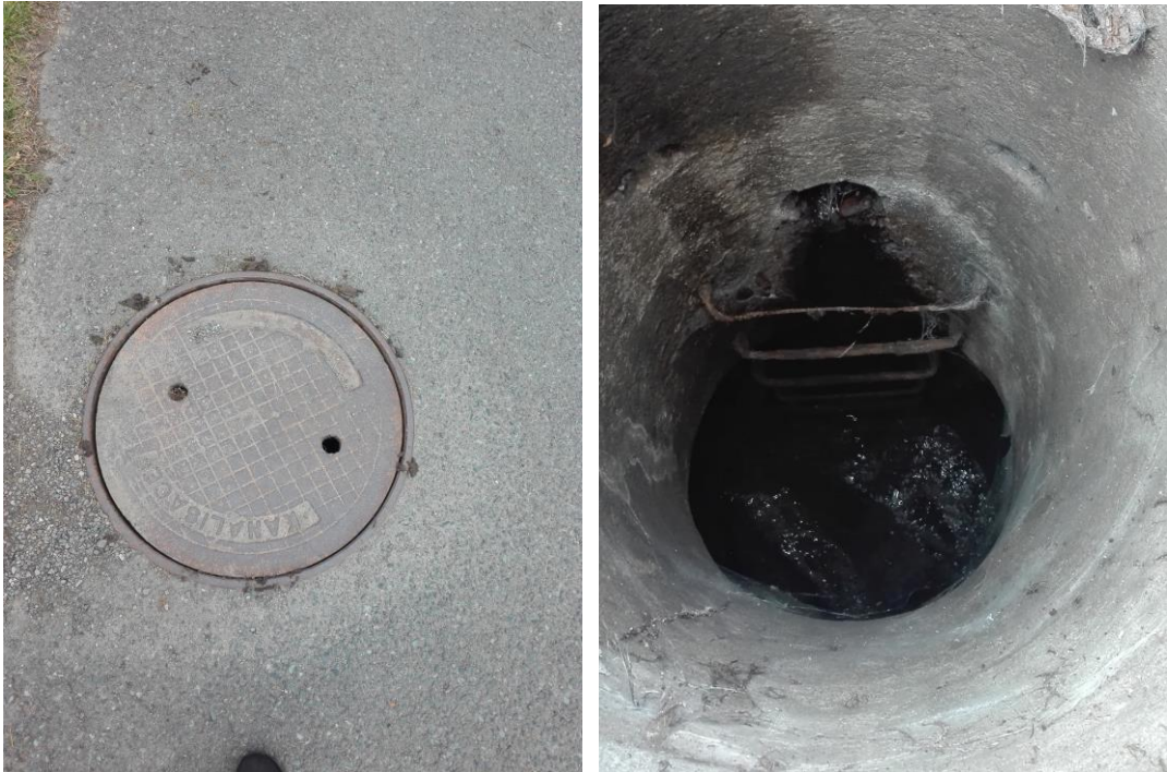
Obrázek 3-1 Šachta Š42 – Pornice
