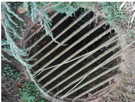
Obrázek 6-2 Stávající šachta ŠL v obci Pačlavice
