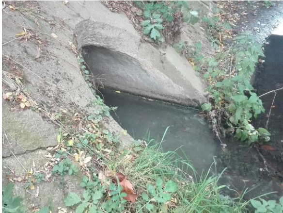
Obrázek 6-5 Stávající výustní objekt VO5
