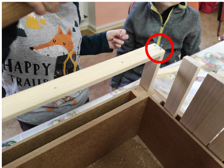
Obrázek 60 Deformovaná hlavička hřebíku z důvodu nepřesnosti
