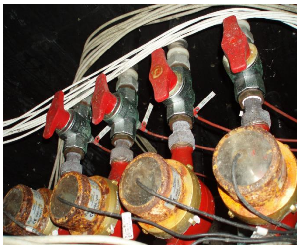
Obr. 23 Impulsní vodoměr a teplotní čidla
