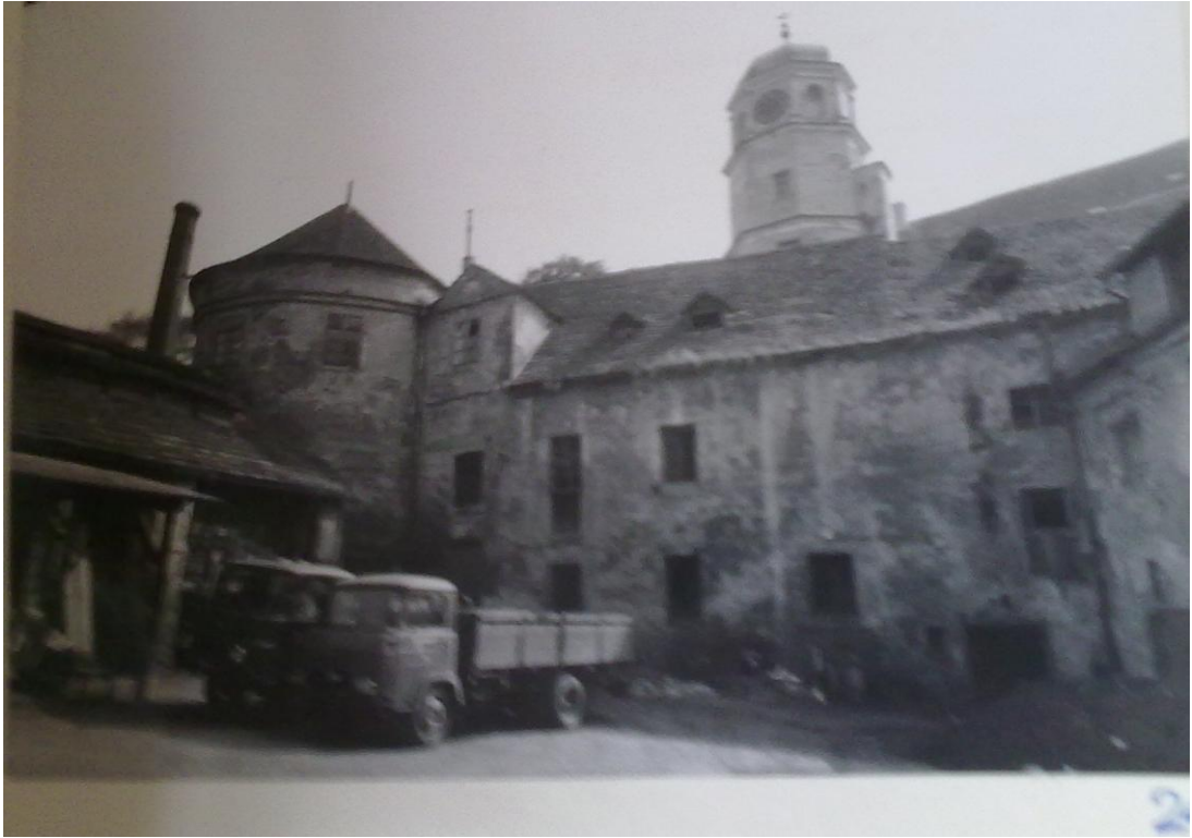
(Obr. 56) severní křídlo
