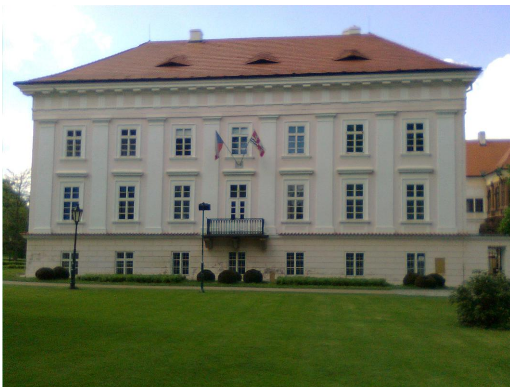
(Obr. 14.) Jihovýchodní nárožní křídlo
