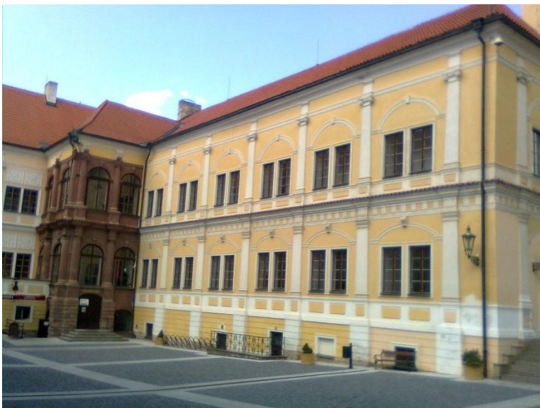
(Obr. 45.) Severní křídlo 1
