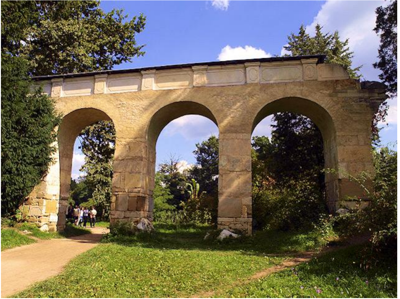
(Obr. 42.) Akvadukt- Lednice
