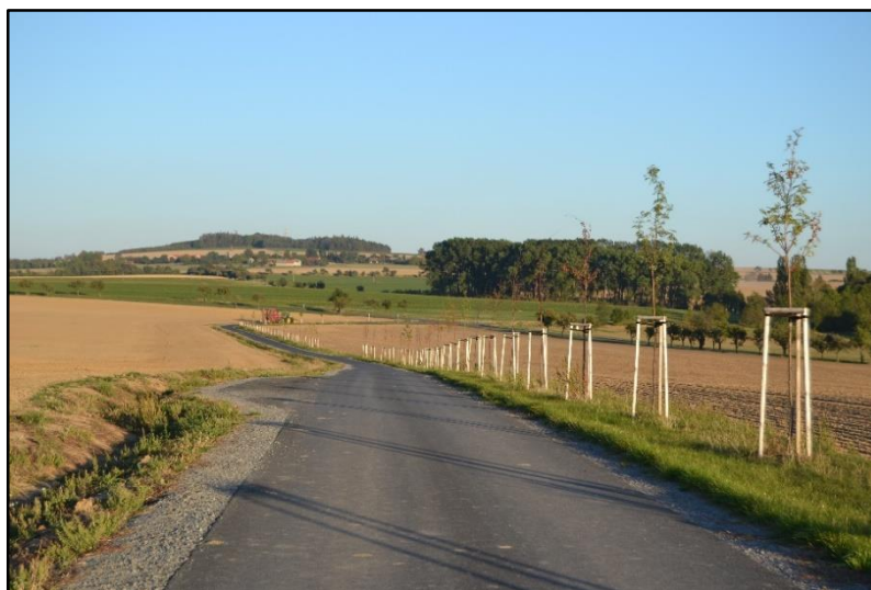
Obr. č. 3 - cesta HPC8 (Hrubešová, 2015)
