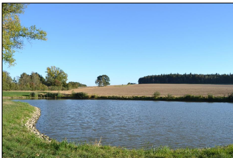
Obr. č. 6 - nádrž N2 (Hrubešová, 2015)
