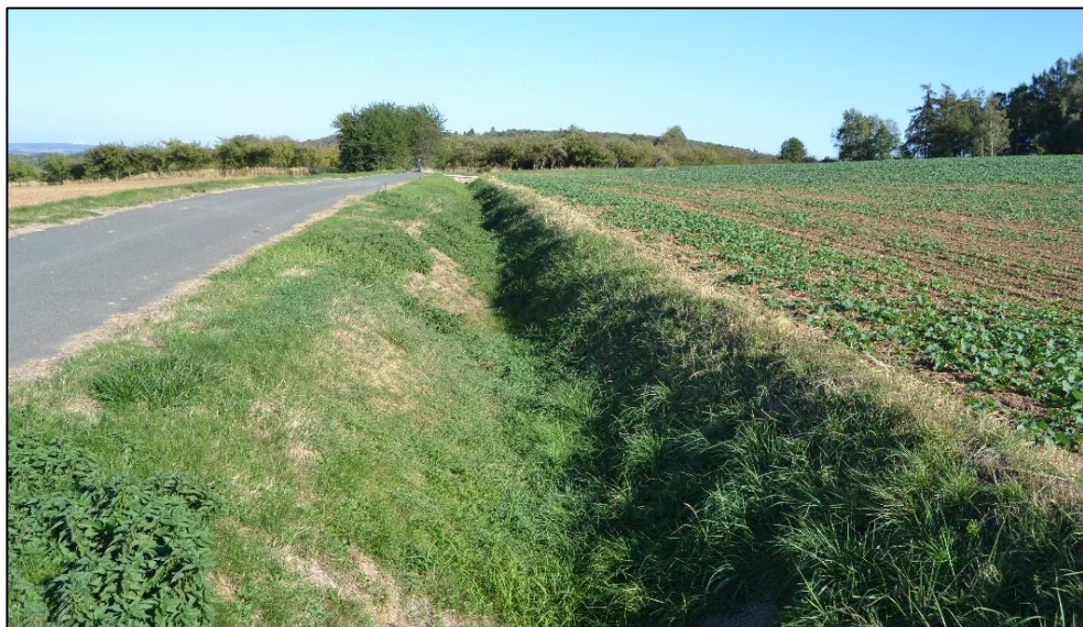
Obr. č. 21 – svodný kanál A2 (Hrubešová, 2015)
