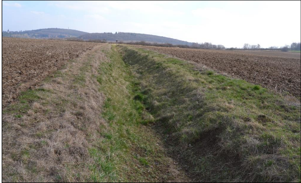
Obr. č. 20 – svodný kanál A1 (Hrubešová, 2015)
