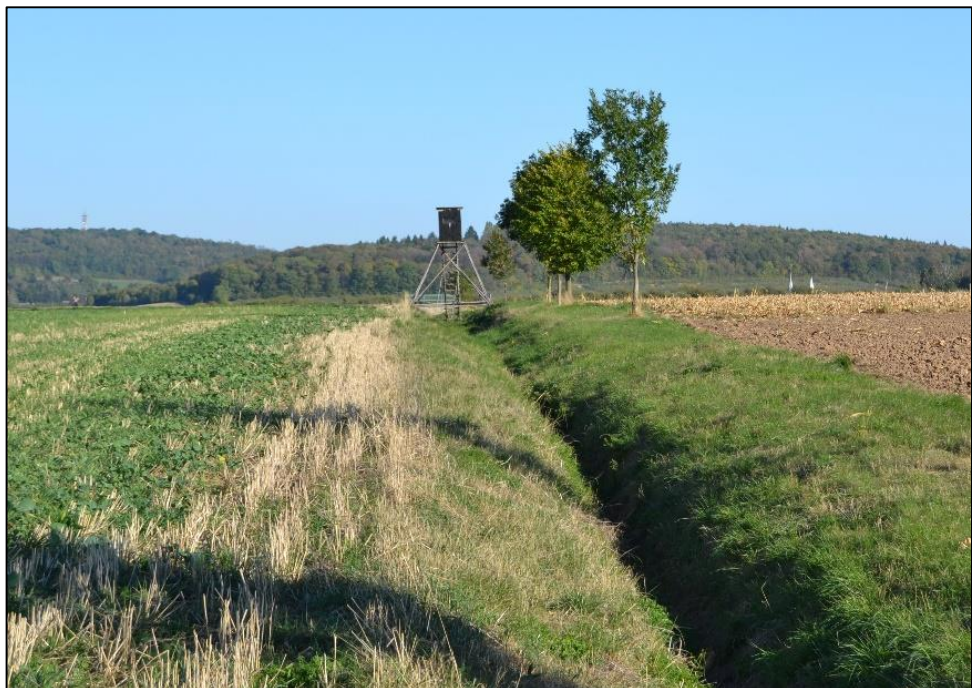
Obr. č. 19 – svodný kanál A s doprovodnou výsadbou (Hrubešová, 2015)
