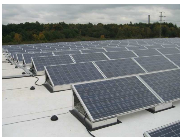
Západní pohled na hotovou instalaci
