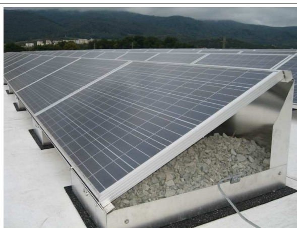
Detail konstrukce s uchycením panelu
