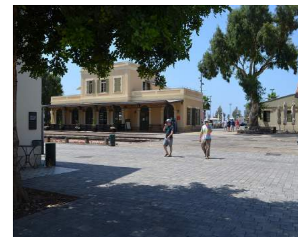
Obr. č. 21 The Station, pohled na hlavní budovu (autor)
