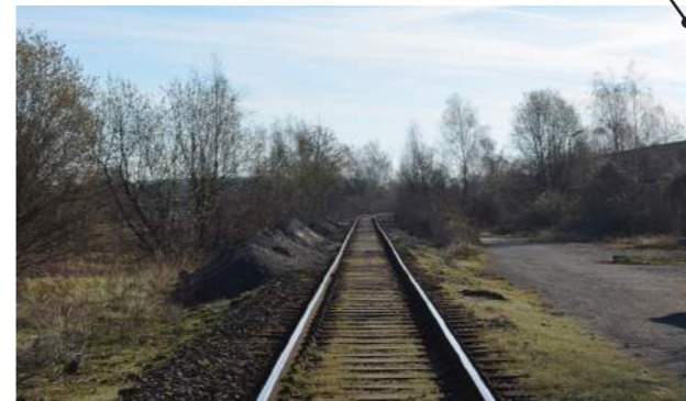
Obr. č. 56 Pohled východním směrem k žel. mostu
