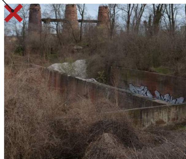
Obr. č. 66 Rudné zásobníky
