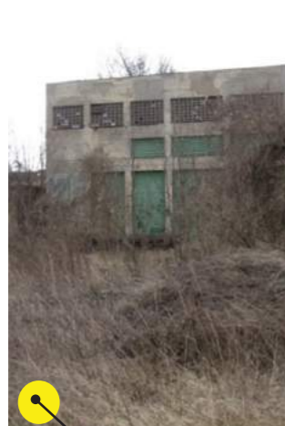
Obr. č. 59 Trafostanice
