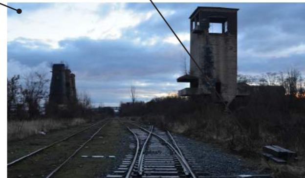
Obr. č. 52 Pohled na železniční věž a váp. pece
