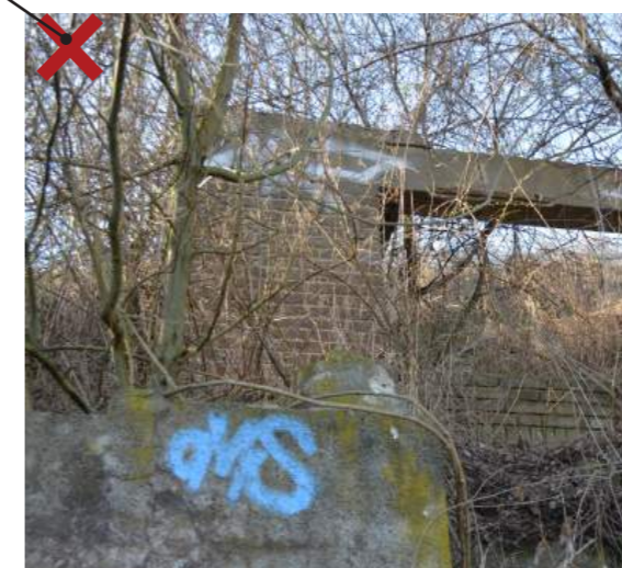
Obr. č. 67 Provozní budova (vše autor)
