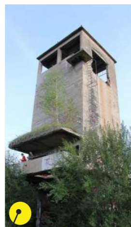
Obr. č. 61 Železniční věž
