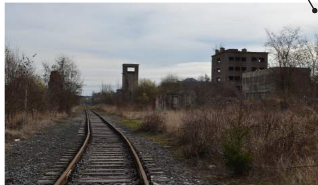
Obr. č. 54 Pohled na východ, stavby v areálu
