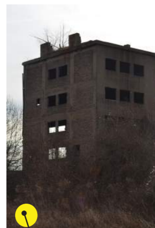
Obr. č. 60 Provozní budova
