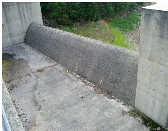
Obrázek 4– Boční bezpečnostní přeliv (www.poh.cz)
