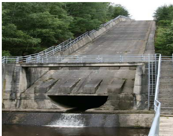
Obrázek 5- Skluz od bezpečnostního přelivu z odpadní štoly (www.poh.cz)
