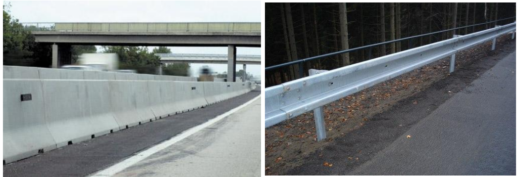
Obr. 9 Betonová a ocelová svodidla
