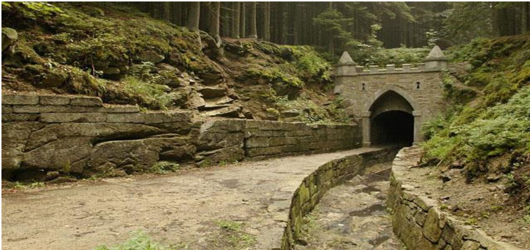
Obr. 34 Schwarzenberský plavební kanál – horní portál tunelu
