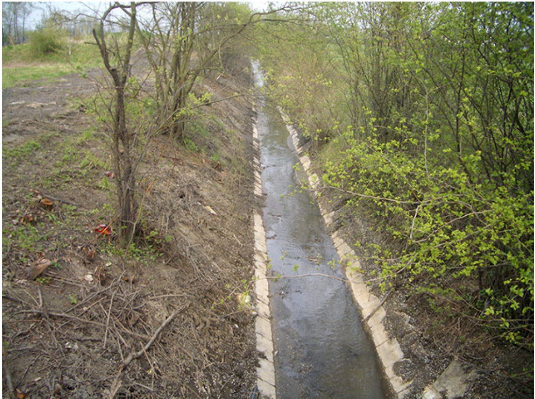
Obrázek č. 5.: Ukázka nevhodného tvaru koryta – koryto je velmi zahloubené, napřímené, lichoběžníkového profilu bez jakýchkoliv známek nepravidelnosti s nevhodným opevněním (Zdroj: www.prezletice.cz ).
