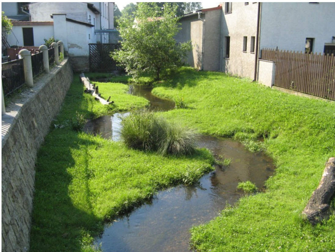
Obr. č. 1.: Ukázka vhodné revitalizace toku v intravilánu ve městě Chrudim – koryto bylo rozvlněno, navrženo dle korytotvorných průtoků, byla vysázena vegetace, složený profil plní funkci estetickou a zároveň splňuje protipovodňovou ochranu. (Zdroj: www.vodavkrajine.cz ).
