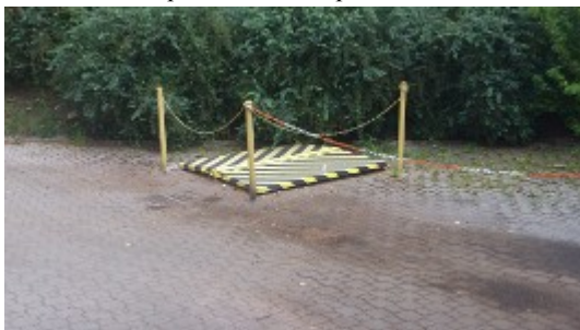
Foto č. 26: Čerpací stanice – lapol
