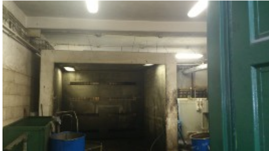
Foto č. 19: Umývárna strojních součástí
