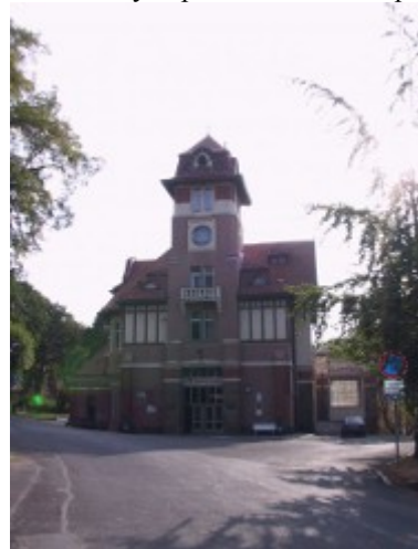
Obr. č. 5: Výstupní stanice LD Imperiál
