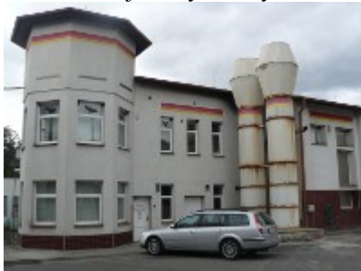
Foto č. 7: Objekt mycí linky
