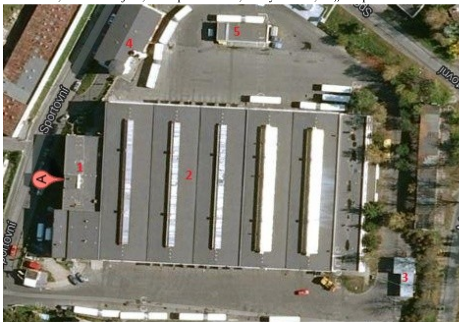
Obr. č. 10: Letecký snímek areálu DPKV, a. s. ve Sportovní ulici 656/1 v Karlových Varech, 1. hlavní budova, 2. zadní objekt, 3. čerpací stanice, 4. mycí linka, 5. „kompresorovna“
