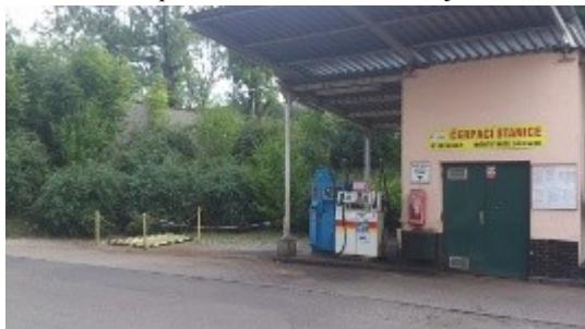
Foto č. 25: Čerpací stanice – tankovací stojan
