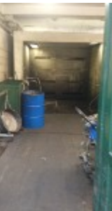
Foto č. 18: Umývárna stroj. součástí
