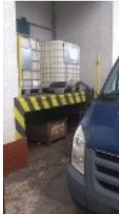
Foto č. 3: Záchytná vana - sklad olejů
