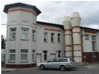
Foto č. 27: Objekt mycí linky
