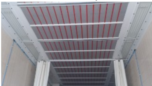
Foto č. 22: Lakovací kabina - strop
