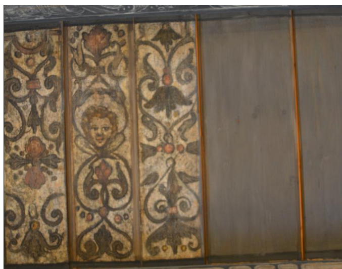
26. Barevná rozdílnost prken záklopového stropu, 1609
