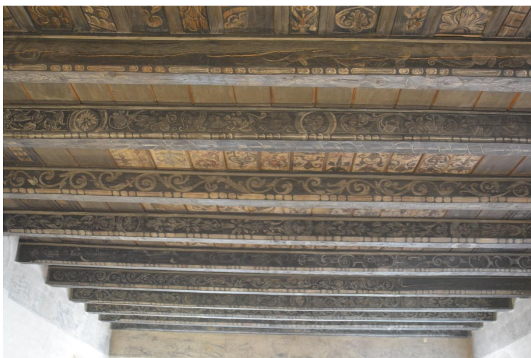
20. Řazení litultovického záklopového stropu tzv. na sráz, 1609
