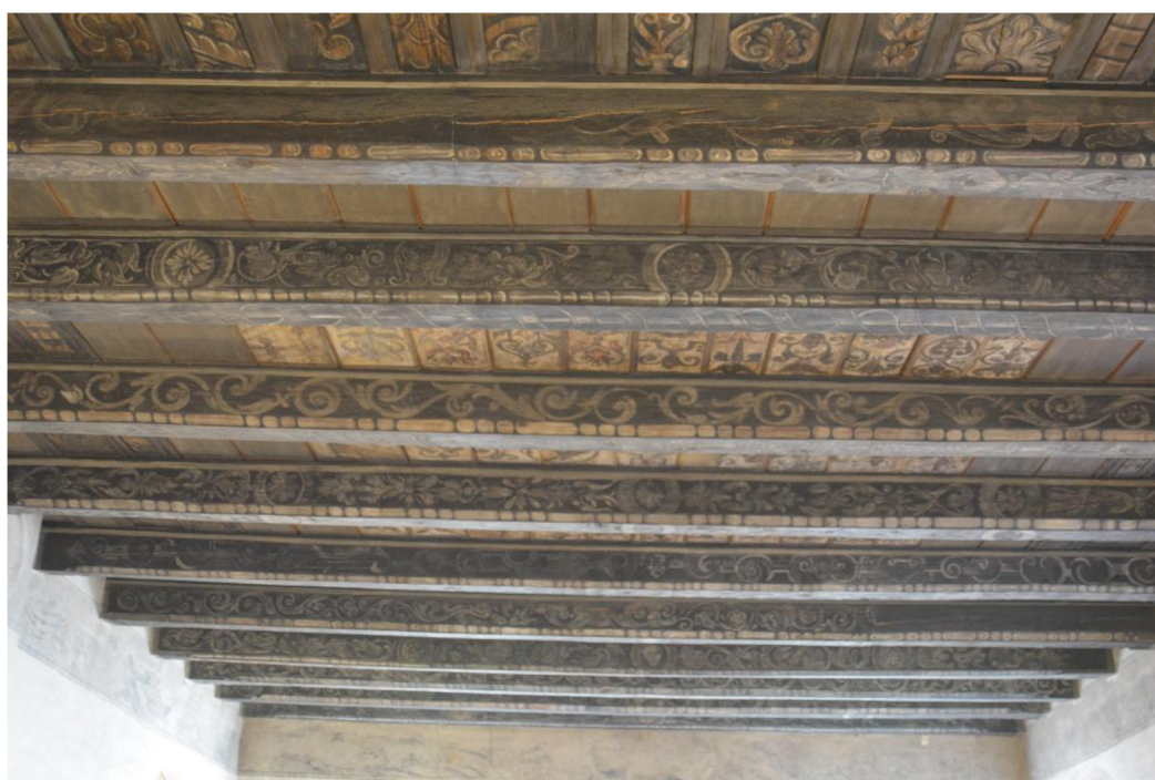
20. Řazení litultovického záklopového stropu tzv. na sráz, 1609
