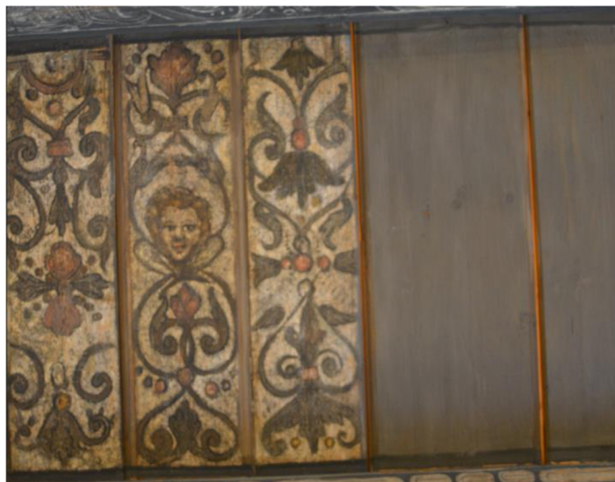
26. Barevná rozdílnost prken záklopového stropu, 1609
