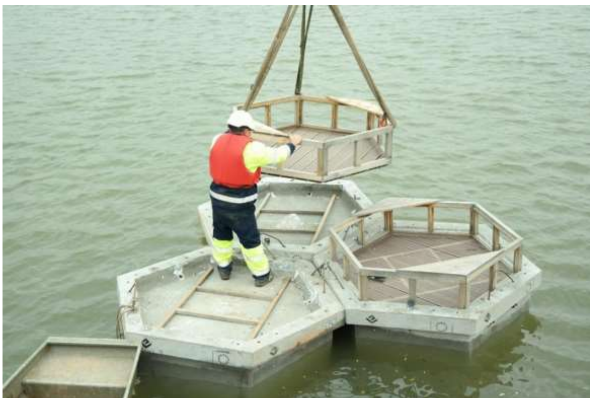
Obr. 22: Plovoucí betonové ostrůvky pro rybáky na vodní ploše pískoven Smiřice a Čeperka. (Autor: ©ESTAV.CZ, Zdroj: https://www.estav.cz/cz/2592.cemex-umistil-dalsi-betonove-ptaci-hnizdiste-na-kralovehradecku )
