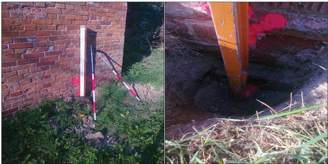
Obr. 10.4. Meranie PN na podzemnej nivelačnej značke Od2 – 20
