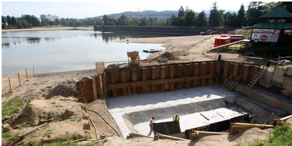
Obr. 19 Výstavba III. Štoly, 2011
