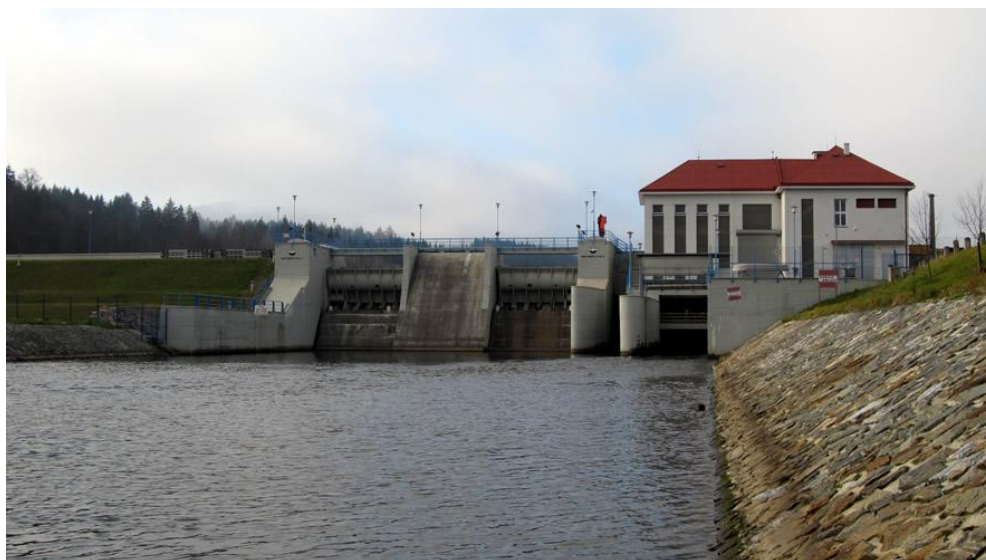
Obr. č. 16 Vodní elektrárna Lipno II, foto autor
