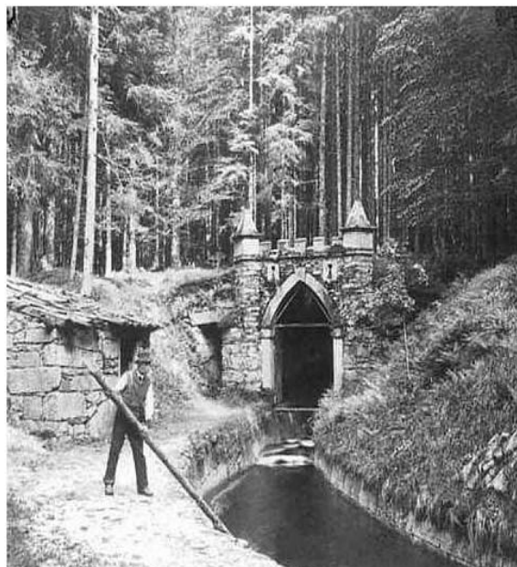
Obr. č. 8. Schwarzenberský plavební kanál – horní portál tunelu, převzato [37]
