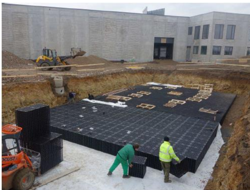
Obrázek 12: Pokládka vsakovacích bloků (zdroj: Novotná a kol., 2015).
