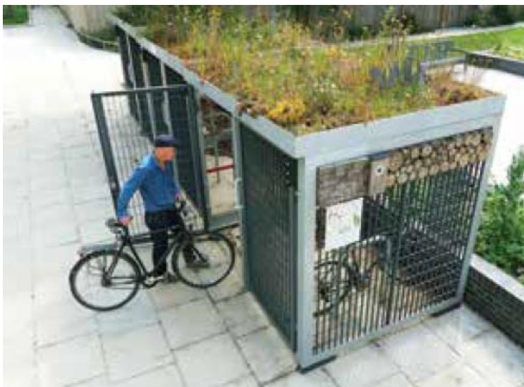
Obrázek 6: Extenzivní vegetační střecha řešená jako přístřešek (zdroj: SuDS Manual, 2015).
