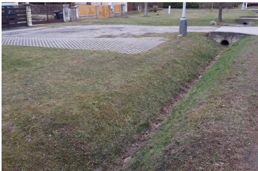
Obrázek 17: Vsakovací příkop v ulici K Zeleným domkům (zdroj: autor).
