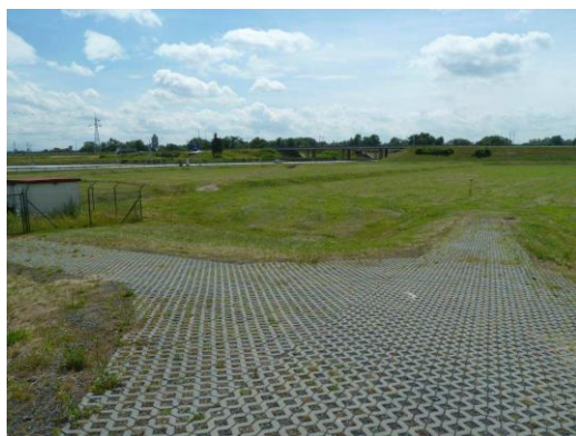
Obrázek 5: Polovegetační tvárnice (zdroj: Novotná a kol., 2015).
