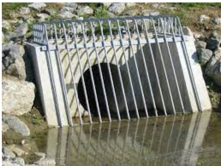
Obrázek 2: Česle (dostupné z: https://www.buesch.com/cs/vyrobky/vretenova-soupatka-hraditka-a-stavitka/prislusenstvi/cesle/ )
