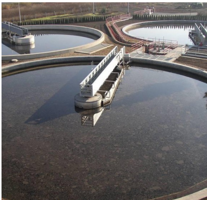
Obrázek 3: Usazovací nádrž ČOV (dostupné z: http://www.hydrosystemy.cz/produkty/33-cistení-odpadních-vod )
