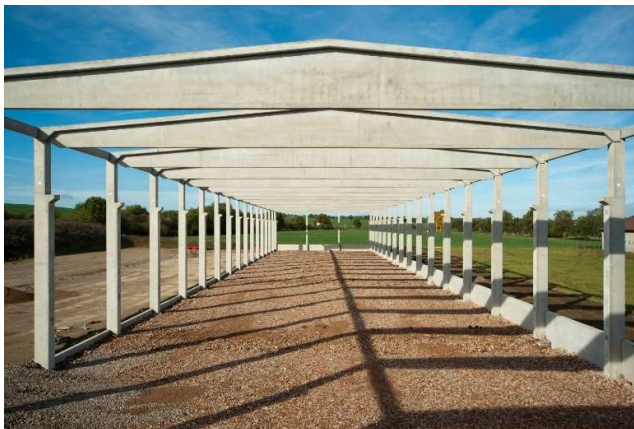
Obr. 19 - Zastřešení haly – betonové vazníky [28]
