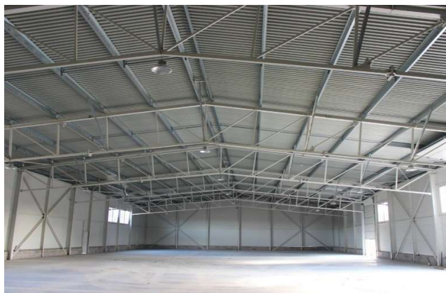
Obr. 21 - Zastřešení haly – ocelové příhradové vazníky [30]
