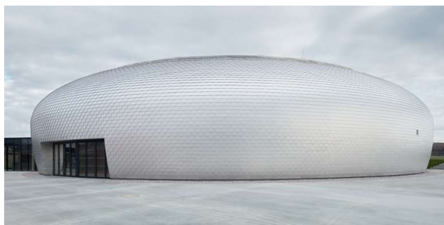
Obr. 27 – Sportovní hala Dolní Břežany [34]
