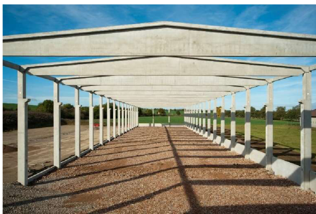
Obr. 19 - Zastřešení haly – betonové vazníky [28]
