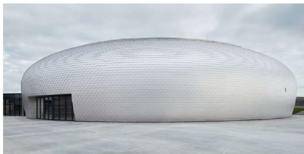
Obr. 27 – Sportovní hala Dolní Břežany [34]
