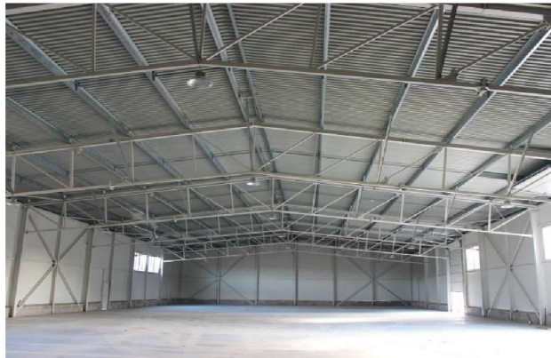
Obr. 21 - Zastřešení haly – ocelové příhradové vazníky [30]
