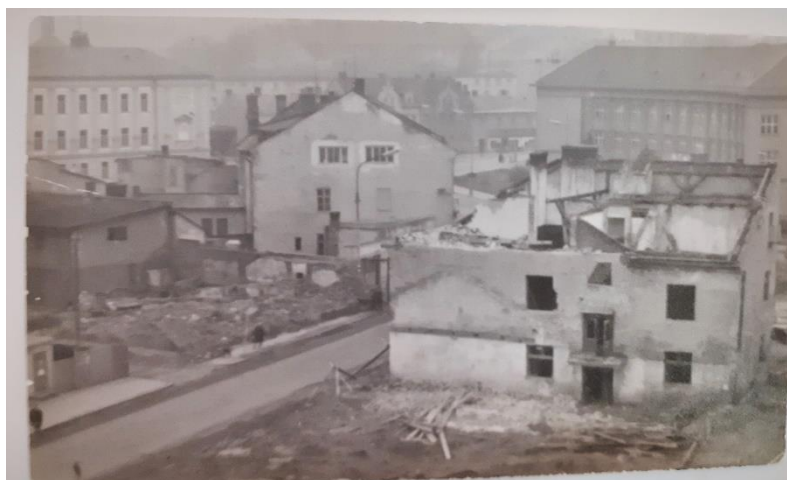
Obr. 1 – Průběh asanace v místě budoucího Kulturního domu Zábřeh. Fotografie dostupná v Archivu Kulturního domu Zábřeh.
