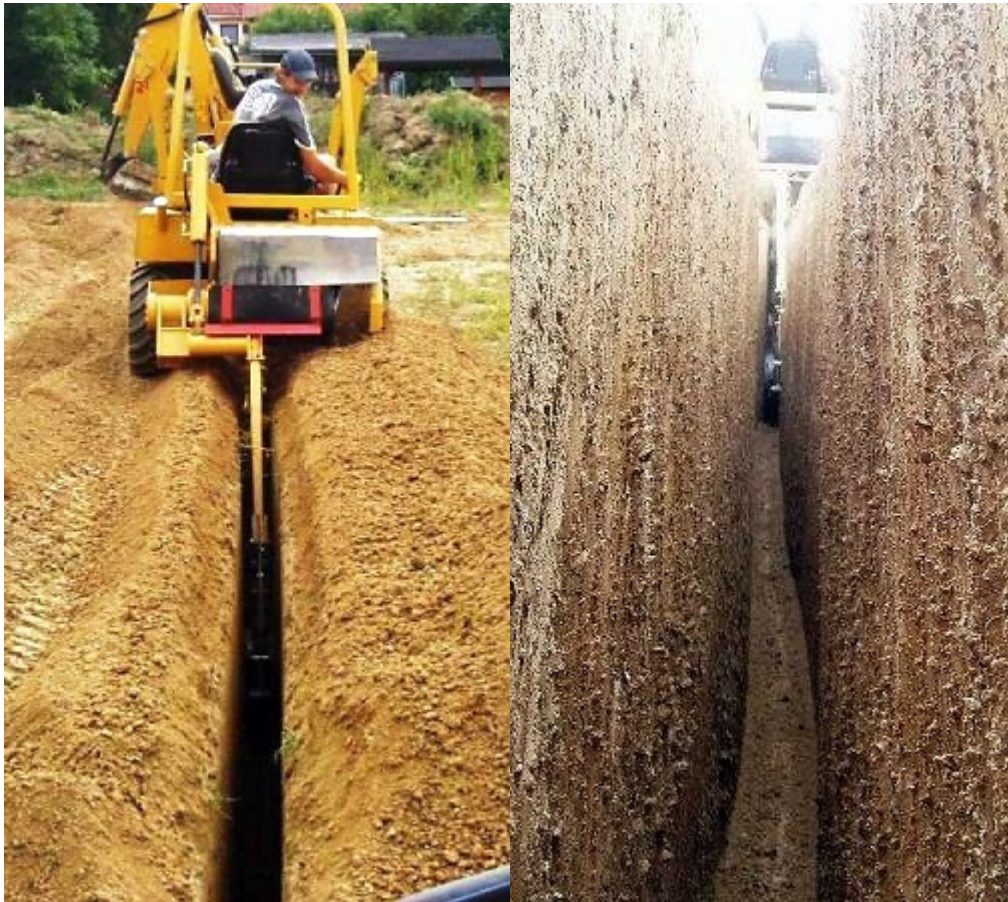
Obr.10 Rýhovač a vzniklá rýha pro uložení potrubí. [11]
