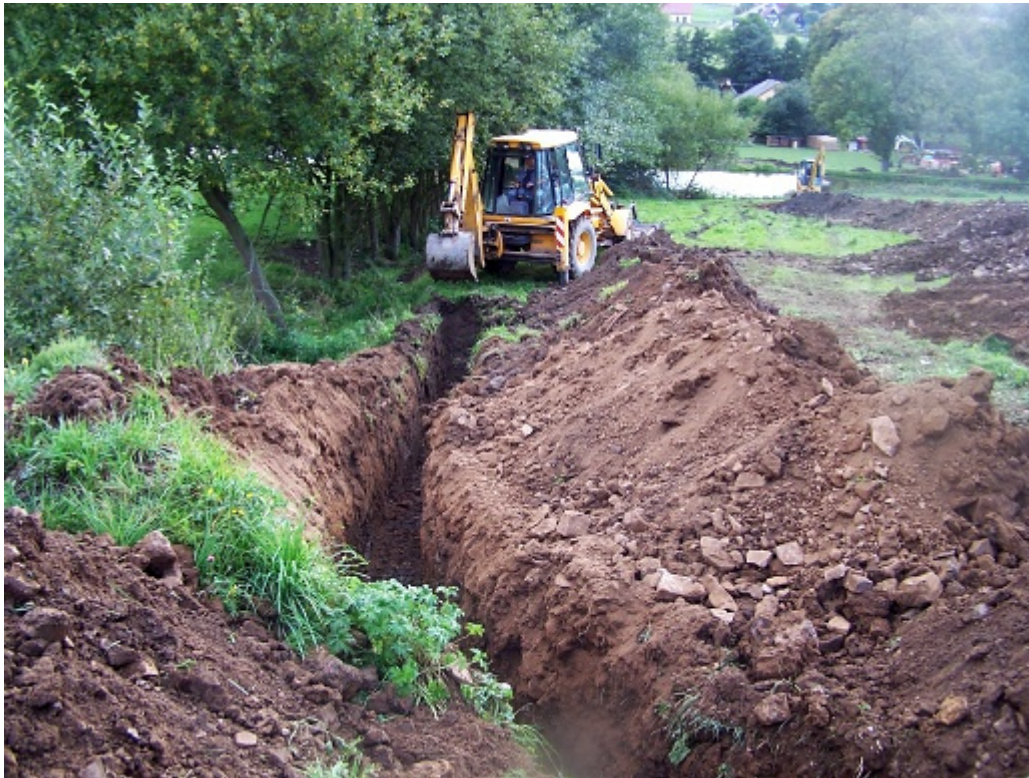
Obr. 7 Provádění výkopu běžným způsobem [11]
