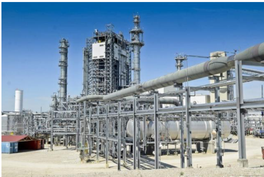
Obrázek 2.2 Průmyslová výroba vodíku zplyňováním uhlí [16]
