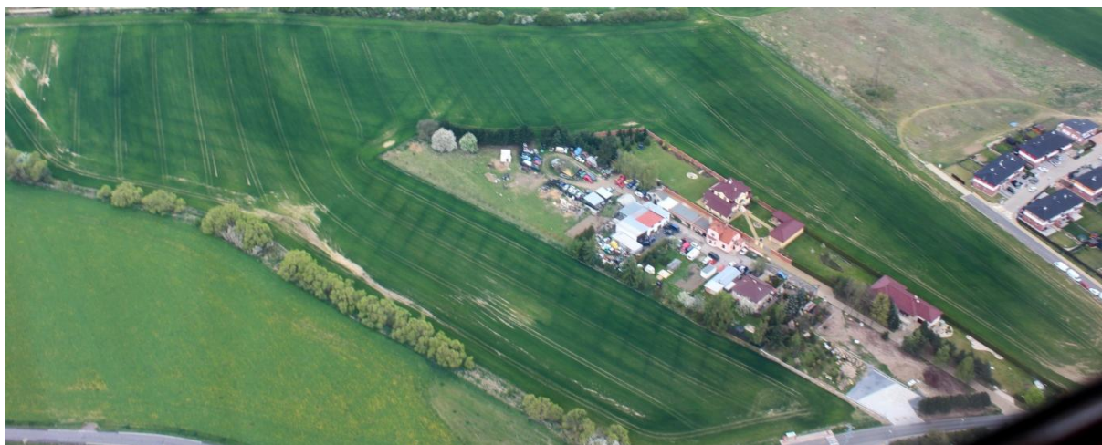
Foto č. 47: Drenážní systém porušený rozrůstající se zástavbou Hájek u Uhřetěvesi (konec dubna 2015)
