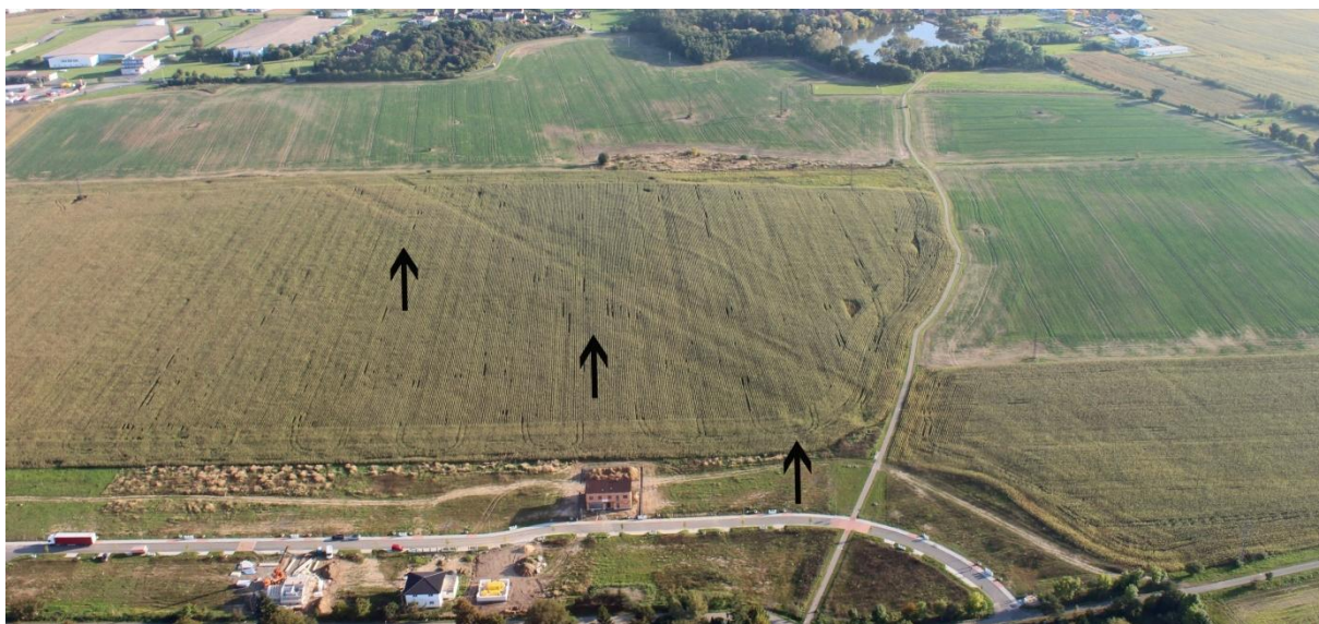
Foto č. 28: Velkokapacitní přivaděč vody z Želivky do Prahy, projev na kukuřici (konec září 2014)
