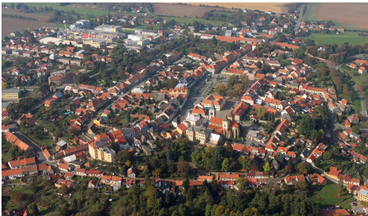
Foto č. 63: Město Kouřim a jeho hradební okruh v říjnu 2014. Snímek ukazuje urbanistickou strukturu sídla, ale ta ze snímku nevystupuje čitelně díky tomu, že se dřeviny začínají barvit a splývat s barvou střech. Architektura nemá potřebné tmavé pozadí. Toto období není pro snímkování urbanistické struktury sídel ideální.
