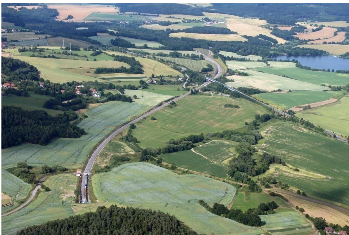
Foto č. 68: Dopravní stavby v krajině Trutav Praha – České Budějovice, tunelový úsek u Tožic, a mezinárodní silnice E55, bariéry v krajině a celková struktura krajiny reagující na tyto objekty (konec června 2014).
