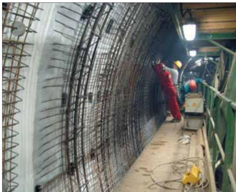
Obr. 3: Montáž výztuže sekundárního ostění [38].
