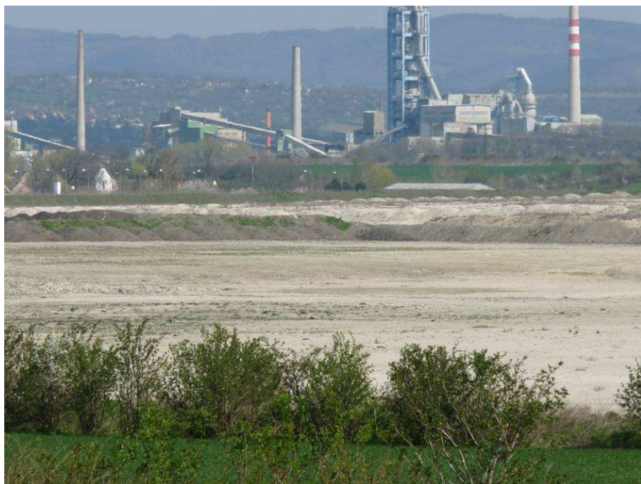
Foto č. 4. : Pohled na vytěžený prostor lomu po provedené sanaci, (Raus,Čížkovice,2010)
