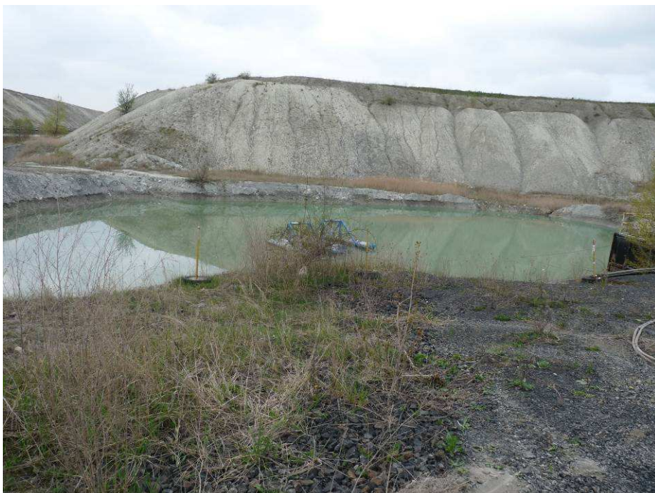
Foto č. 3. : Pohled na hlavní čerpací stanici důlních vod, (Raus, Čížkovice, 2010)
