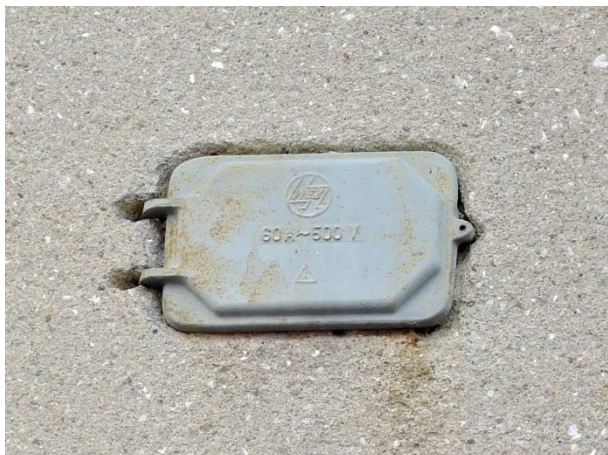
Obrázek 6: Hlavní domovní pojistková skříňka (Zdroj: vlastní fotografie)
