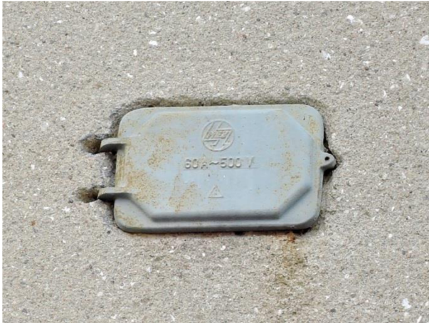
Obrázek 6: Hlavní domovní pojistková skříňka (Zdroj: vlastní fotografie)
