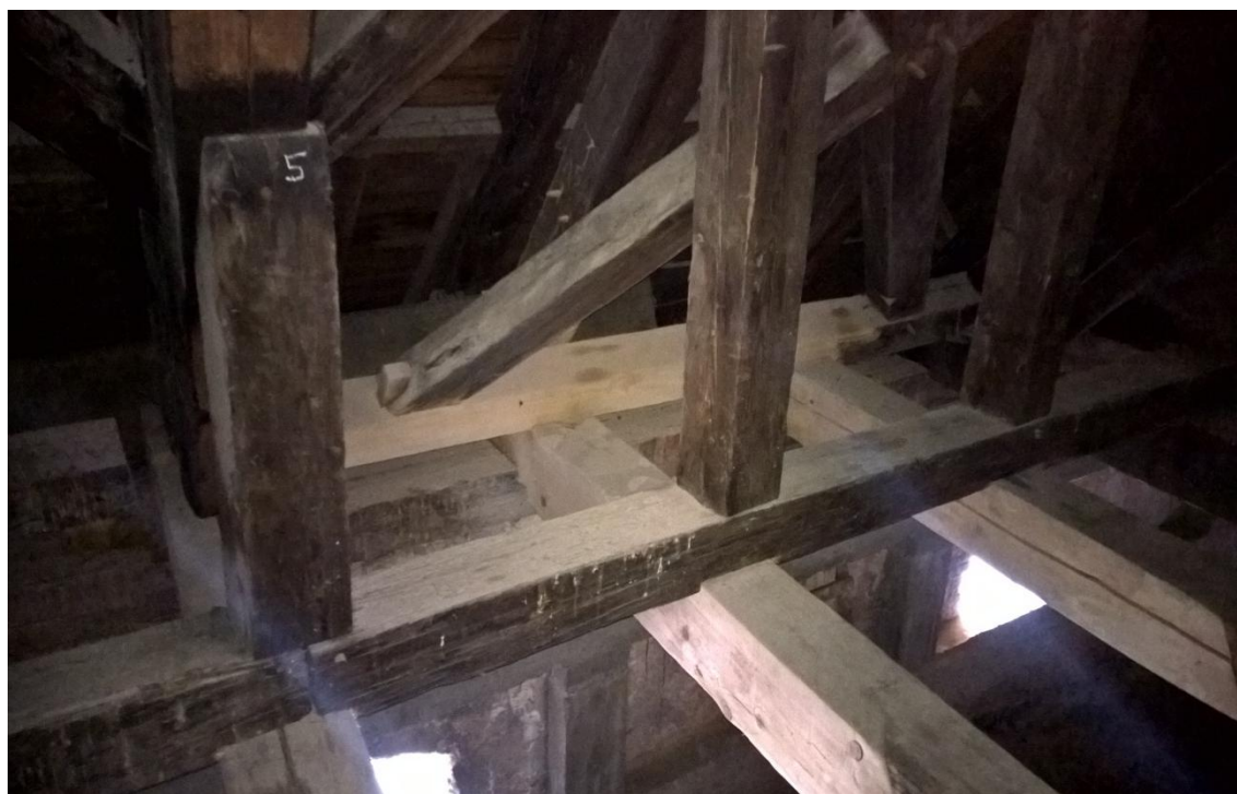
Obr. 52 Nahrazení zhlaví vazných trámů a části pětibokého prahu z jedlového dřeva. Foto: Bc. Radomír Dvořák
