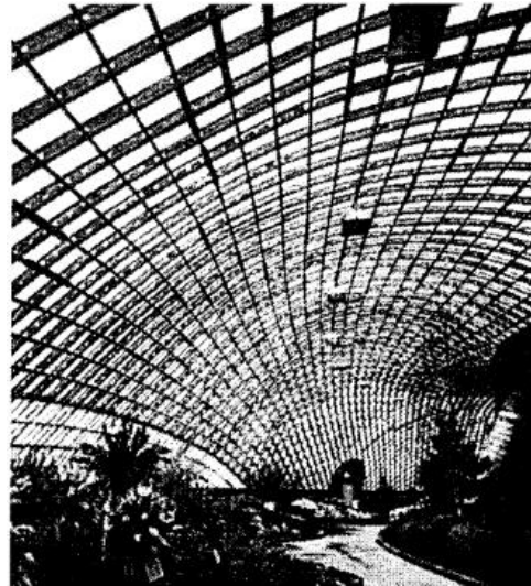
Obr.14 Dřevěná síťová konstrukce (Kuklík 2005).
