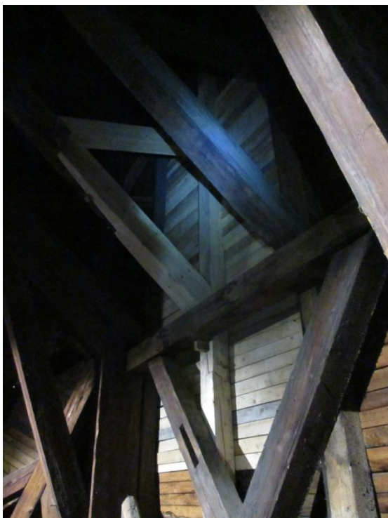
Obr. 50 Správné provedení výměny krokve, hlavy hambalku a krokevní vzpěry v rámci projektu Monumentum sacrum Brunense. Foto: Bc. Jakub Hapala
