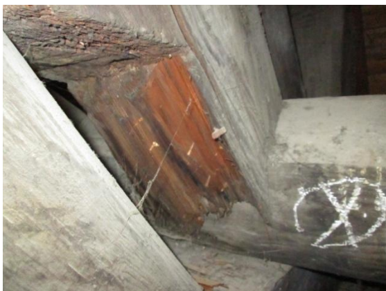
Obr. 54 Uhnílý čep sloupku ležaté stolice v osazení do pětibokého prahu způsobené proužkovaného ( Anobium punctatum ). Trámovkou Obr. 55 Výletové otvory Červotoče proužkovaného ( Anobium punctatum ).
