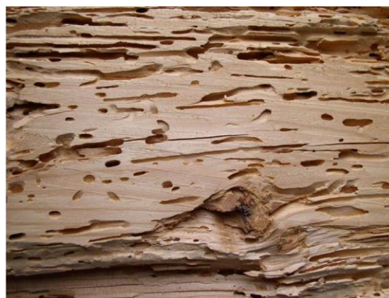
Obr.38 Požerky způsobené Tesaříkem krovovým ( Hylotrupes bajulus ) (www.atlasposkozeni.mendelu.cz).
