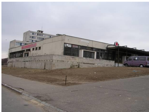
Obrázek 1 : Polyfunkční centrum před rekonstrukcí
