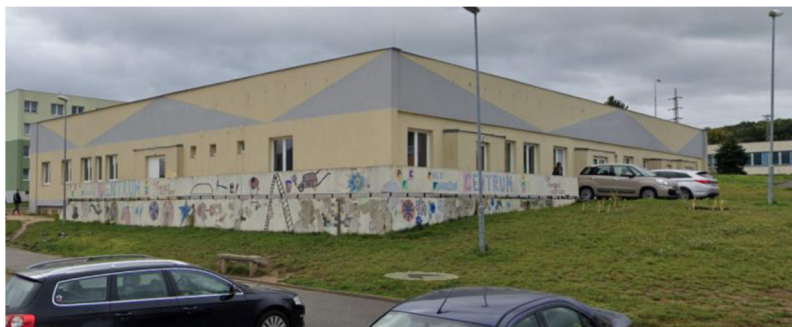
Obrázek 2 : Polyfunkční centrum po rekonstrukci
