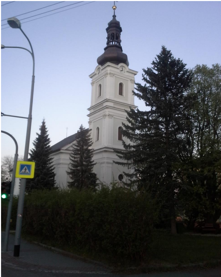
Obr. 3 Kostel sv. Benedikta v Kostelci (O. Šmíd, 5. 4. 2018)
