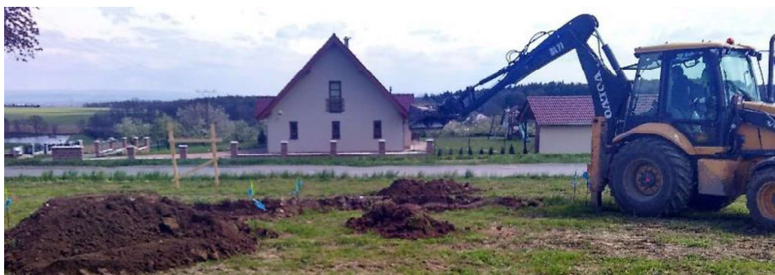
Obrázek 6 – Skrývka zeminy (ilustrativní obrázek) 53
