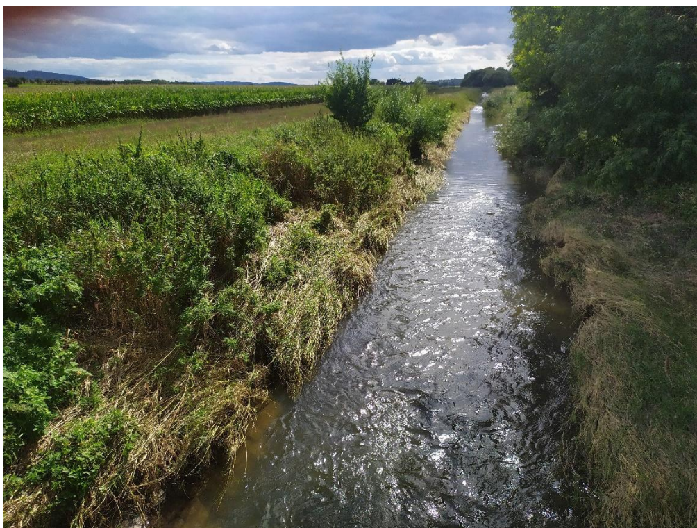
Obr. č. 15 Nevhodně upravené koryto říčky Jevíčky u obce Chornice. Autor: Barbora Tomanová. Datum: 1. 9. 2022.
