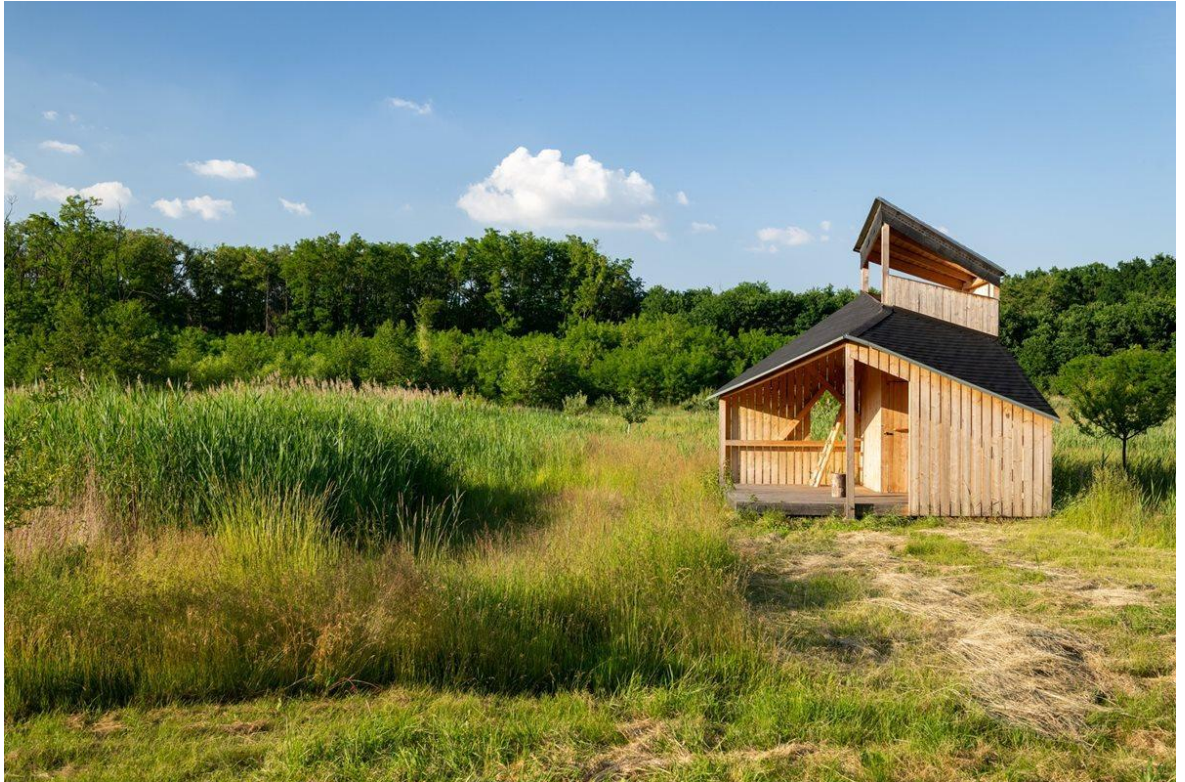
Obr. č. 6 Uměle vybudovaný mokřad a extenzivní sad s pozorovatelnou. Autor: Vojtěch Herout.
