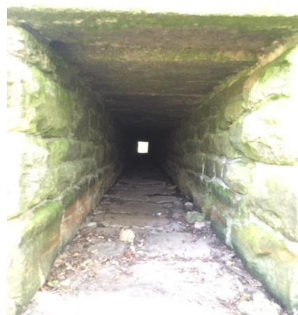
Obr. 17, 18: Zděný propustek pod železniční tratí na rozhraní katastru Milevska a Líšnice u Sepekova, zdroj: Kateřina Vavříková, 2020.
