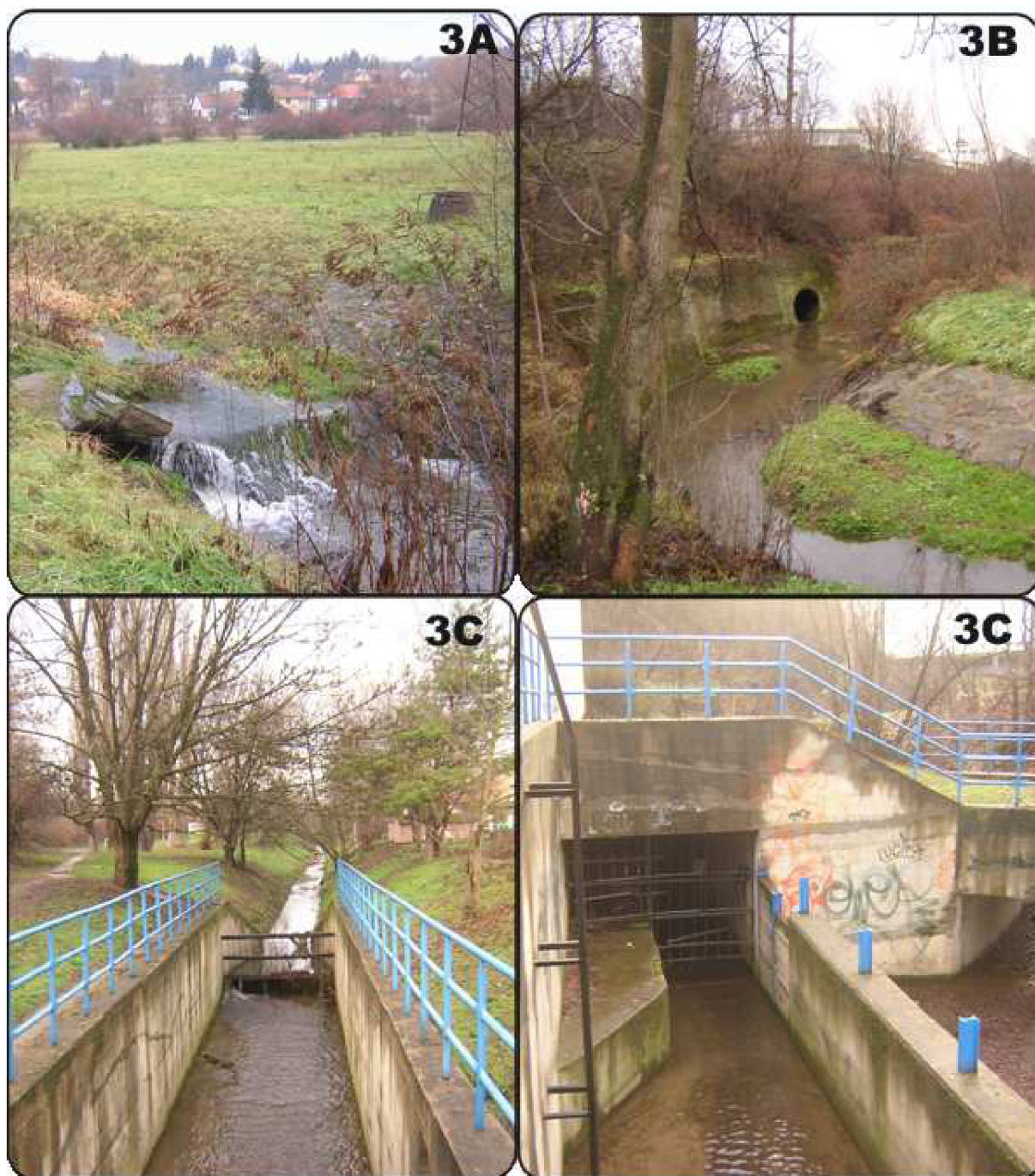
Obr. P.2: Odběrová místa povrchové vody - potok Ponávka (3A-3C)
