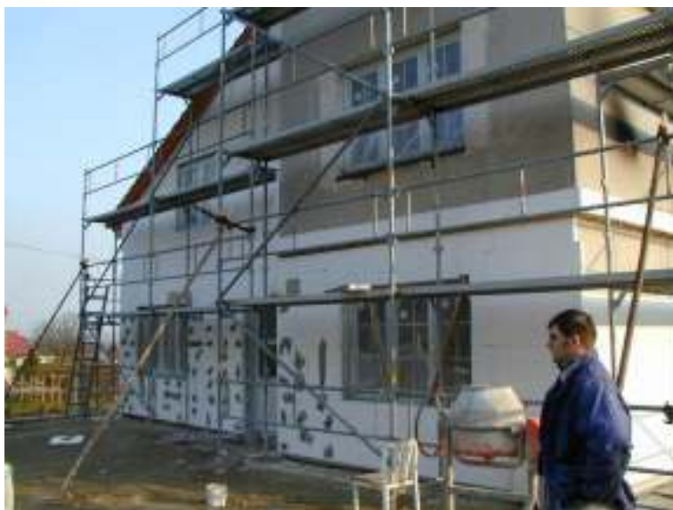
Obrázek 11 - Zateplování objektu. – vlastní zdroj
