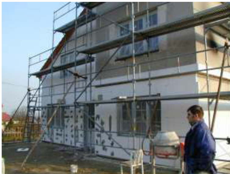
Obrázek 11 - Zateplování objektu. – vlastní zdroj
