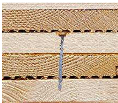
Obr.14- Řez stěnou s hřebíky. (MHM, b .r.)
