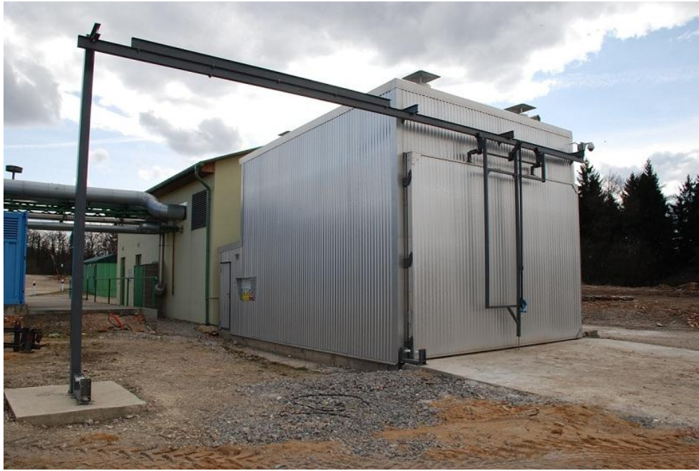
Obr. č. 39: Sušárna dřevních štěpků, která se nachází hned vedle kogenerační jednotky (zdroj: Autor).
