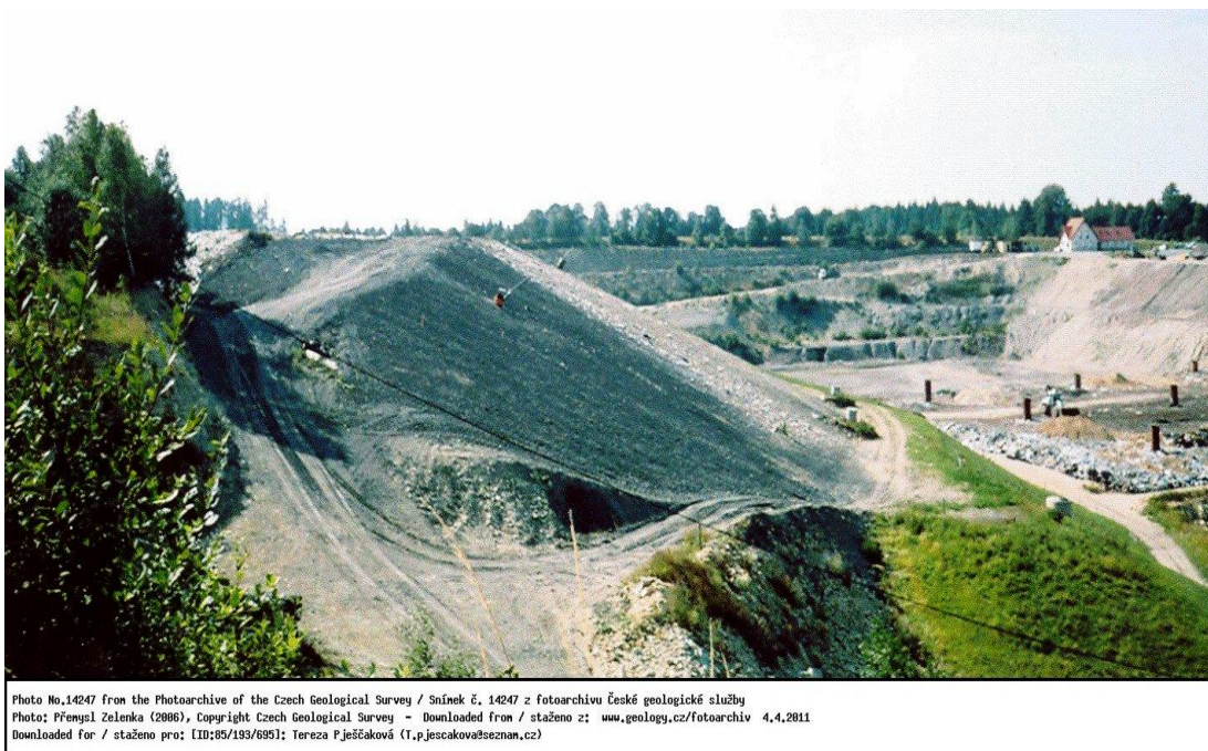
Obr. č. 30: Pohled na zrekultivovanou část skládky (svah uprostřed) a část v provozu (zdroj: Česká geologická služba).
