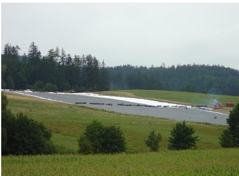
Obr. č. 16: Rekultivace skládky TKO - obec Hošťálková. Pokryv fóliovým těsněním. (zdroj: http://www.sita.cz/page/2139.projekty-sita-cz-ekologicke-stavby/ ).
