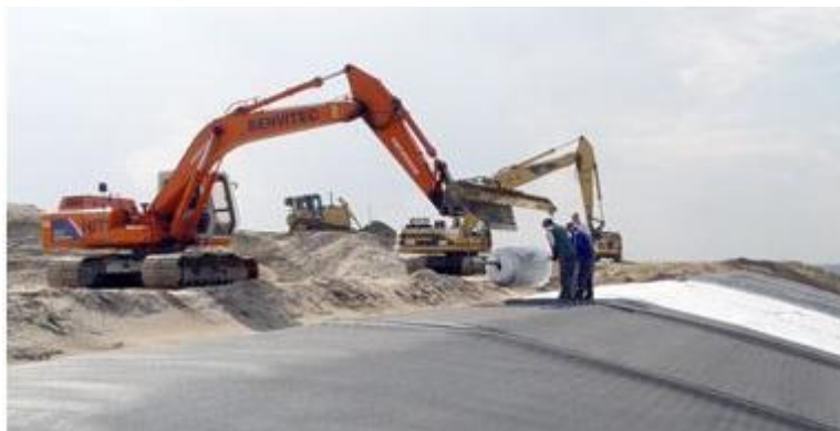
Obr. č. 10: Instalace drenážních geokompozitů při založení nové skládky (zdroj: http://www.geomat.cz/skladky-odpadu/40 ).
